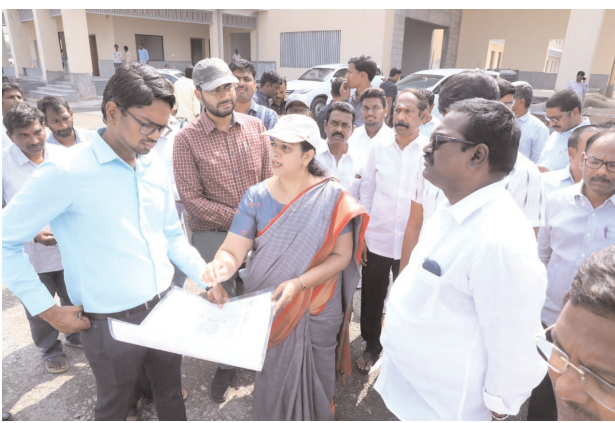
నూతన కలెక్టరేట్ భవననిర్మాణ పనులు
